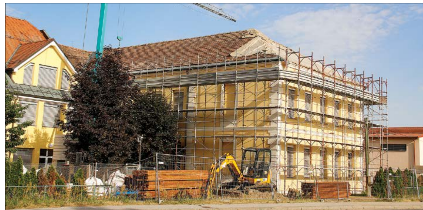
Dela na šolski zgradbi se nadaljujejo.
