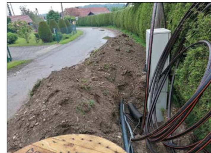
V Hajdošah so v zemljo položili nizkonapetostno omrežje, telekomunikacijske cevi, izvajajo pa tudi rekonstrukcijo javne razsvetljave.
