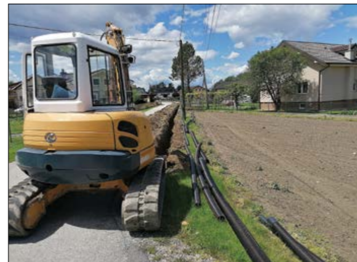
V Hajdošah so v zemljo položili nizkonapetostno omrežje, telekomunikacijske cevi, izvajajo pa tudi rekonstrukcijo javne razsvetljave.
