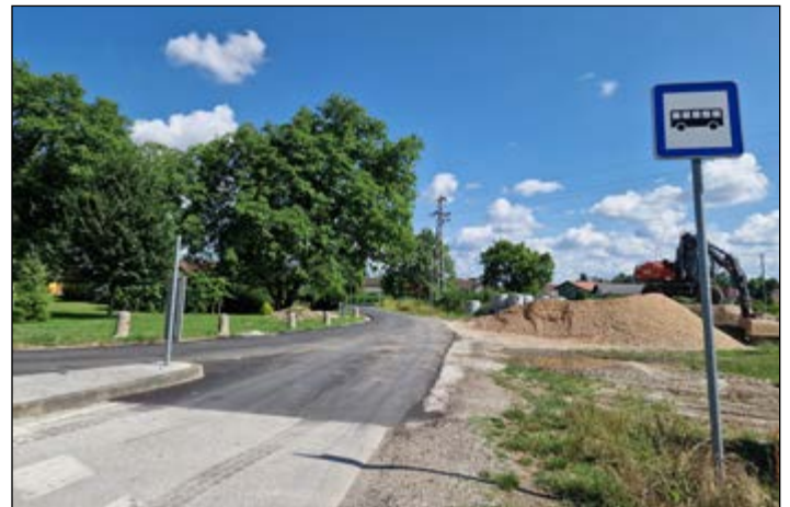
Gradbišče v Hajdošah
