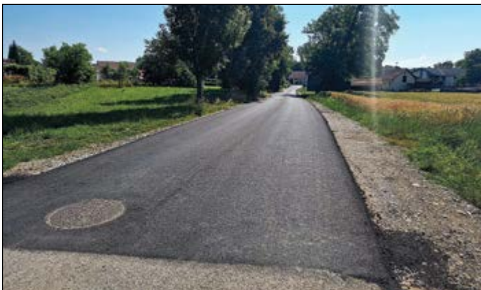
V Skorbi so že izvedena asfaltna dela na nekaterih odsekih.
